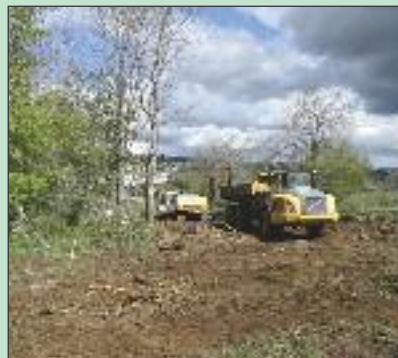
Futur emplacement du lotissement du Murets.
