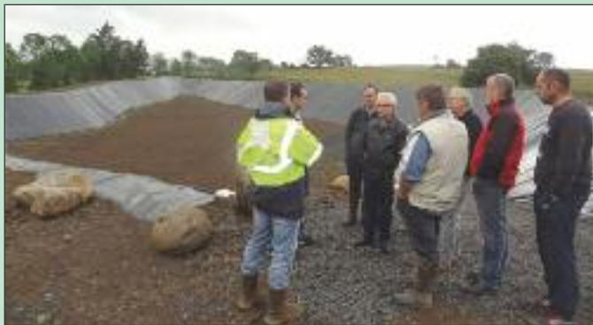
Visite du chantier le 10 juillet dernier.
